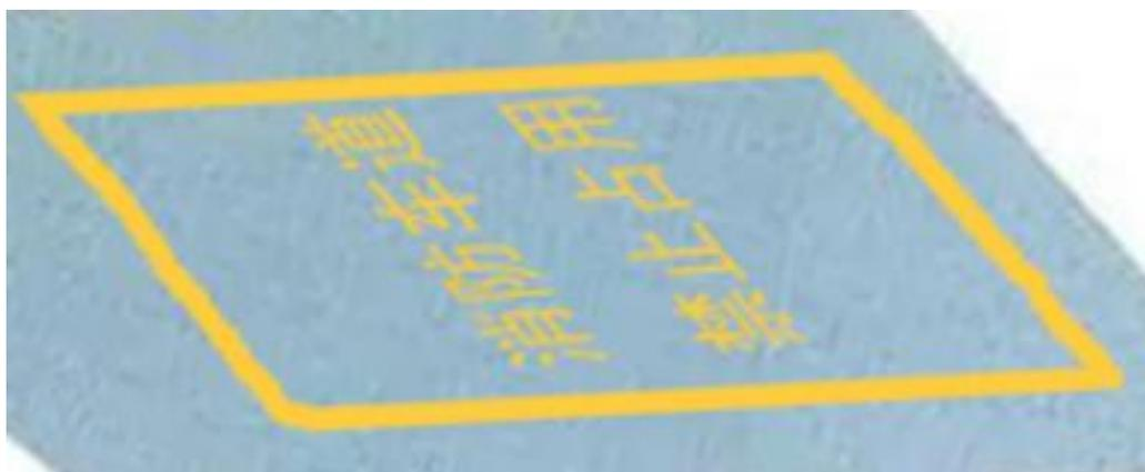
（三）在单位或者住宅区的消防车通道出入口路面，按照消防车通道净宽施划禁停标线，标线为黄色网状实线，外边框线宽20厘米，内部网格线宽10厘米，内部网格线与外边框夹角45度，标线中央位置沿行车方向标注内容为“消防车道禁止占用”的警示字样；
